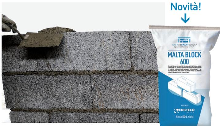
Qualora richiesto, correggere l'allineamento come eseguito durante la posa del primo corso. Nel caso di strutture armate si consiglia l'utilizzo di idoneo traliccio zincato, il quale oltre a ripartire il carico, riduce la creazione di cavillature. Nel caso di pareti interne, qualora le medesime dovessero intersecarsi, si consiglia di realizzare morse al fine di aumentarne la stabilità ed evitare la creazione di fessurazioni.
